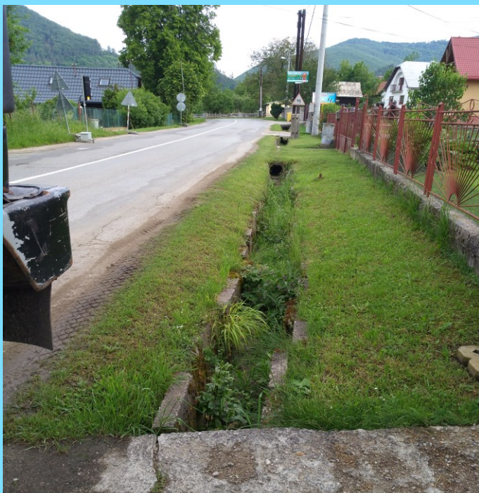
Takto vyzerala krajnica a rigol pred budovaním kanalizácie
