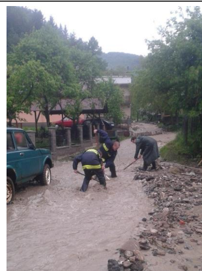
Dobrovoľní požiarnici aktívne pomáhali počas povodní a pri odstraňovaní ich následkov.
