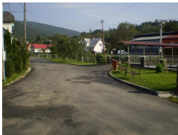
Miestna komunikácia po rekonštrukcii
