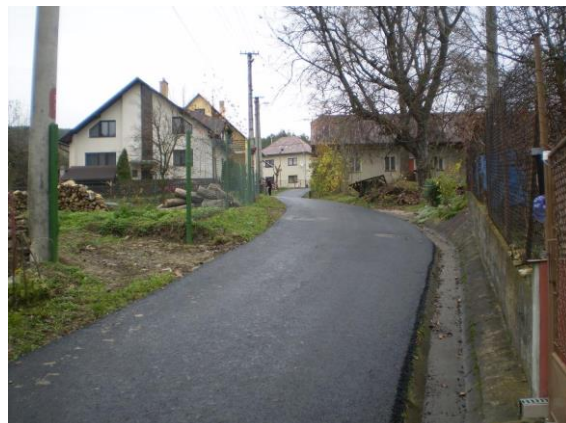
... a po rekonštrukcii
